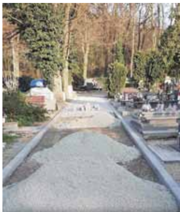
Remont alejki na cmentarzu komunalnej - kostka płukana sprawdzila się, będą kolejne
