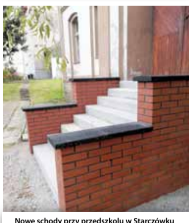
Nowe schody przy przedszkolu w Starczówku
