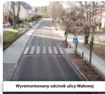
Nowa droga w Kalinowicach Dolnych
